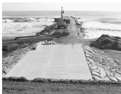
一松海岸、工事中の突堤 2007.12
