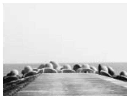
進む海岸侵食・一松海岸突堤
