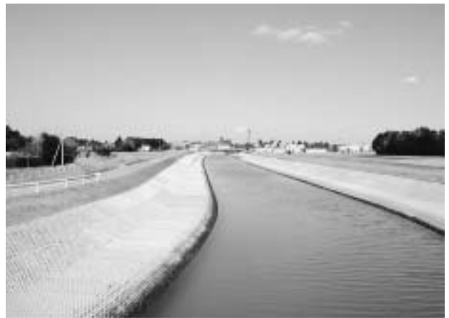
▲完成した高聖橋～市場橋間
