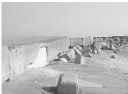
波に破壊された大東漁港の防波堤
