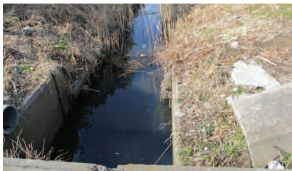
保安全管理を待つ排水路
