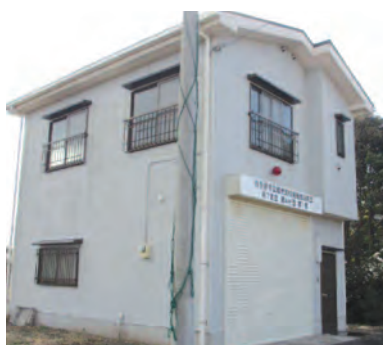
消防団の消防庫
