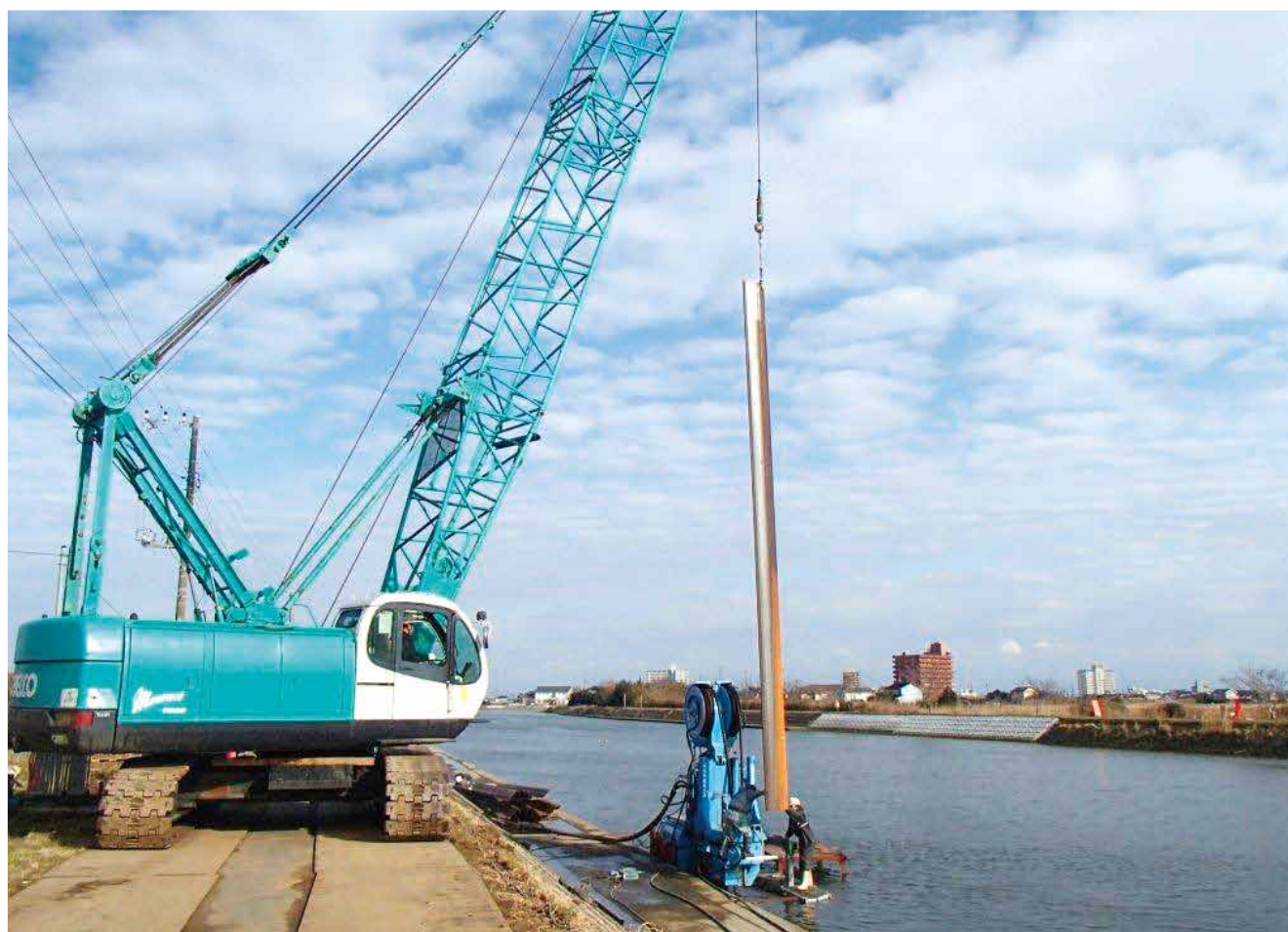
▲ 南白亀川の高上げ工事進む
