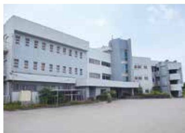
解体撤去をする白子荘
