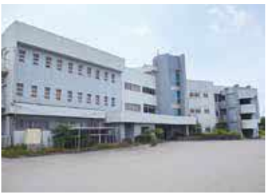
解体撤去をする白子荘
