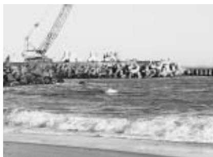
太東漁港の工事現場
