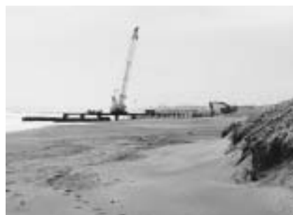
吐出口工事と土提・幸治海岸
