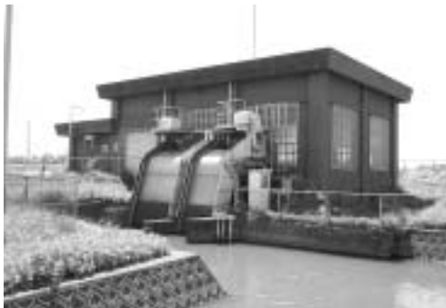
古所排水機場
