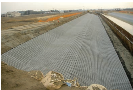
内谷川 改修工事
