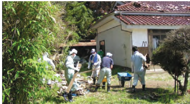
ガレキ等の撤去作業をする派遣職員
