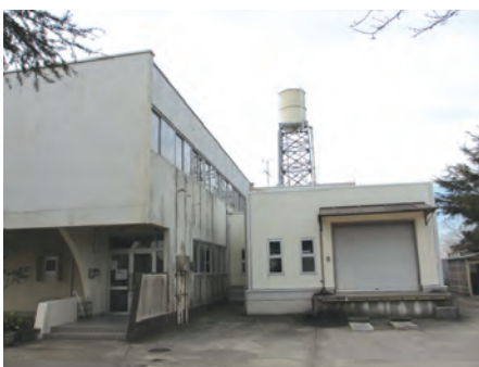
白濁小学校避難階段(予定場所)
