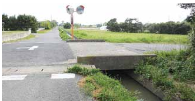
用水路と交差する町道
