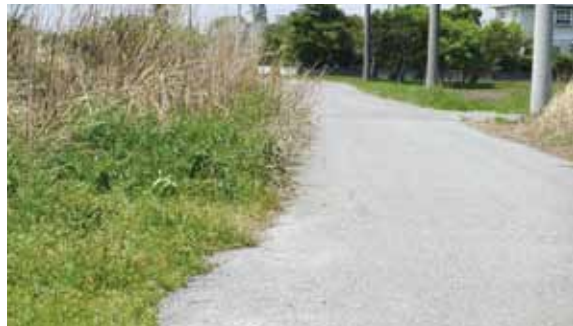
繁茂する町道の路肩
