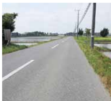
歩道設置工事予定の109号線
