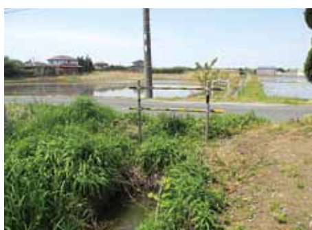
排水路のガードポール
