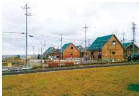
建設が進む町営住宅
