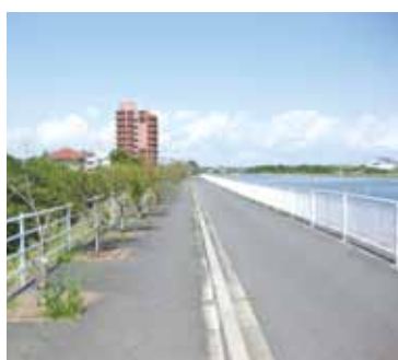
南白亀川堤防
