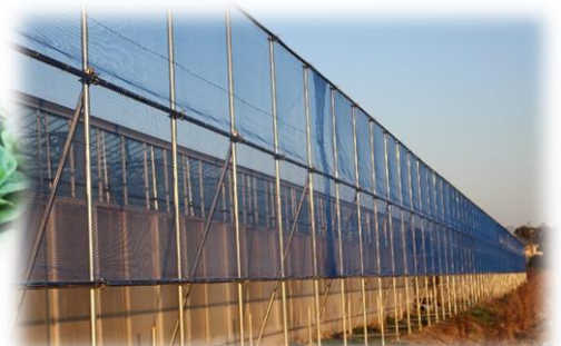
【施設強靱化(防風ネット設置)にも取り組む】
