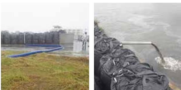
応急ポンプによる排水
