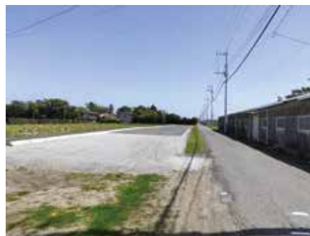
工事の進む県道茂原・白子バイパス
