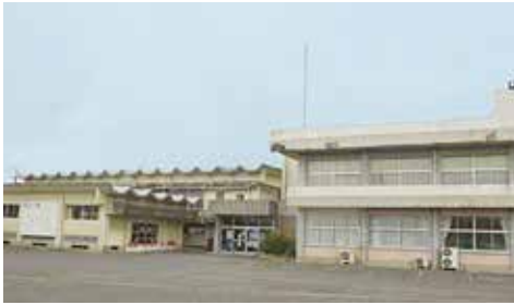
老朽化した公民館及び国民体育館
