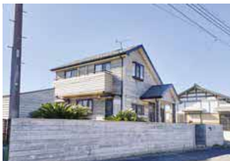
お試し住宅の現状
