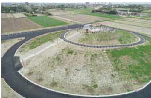
津波避難施設の築山
