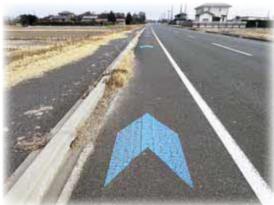
車道混在型の道路
