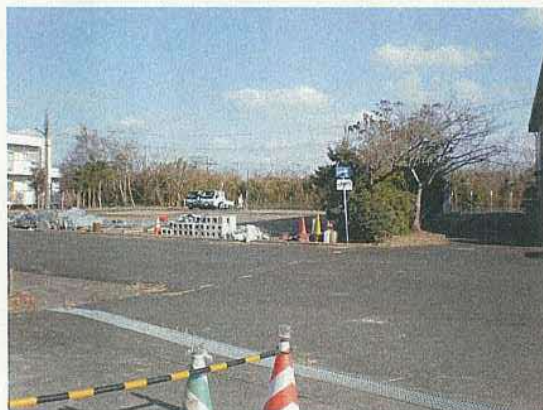
写真 5. 3. 13 労災リハビリテーション 千葉作業所 (敷地北側)
