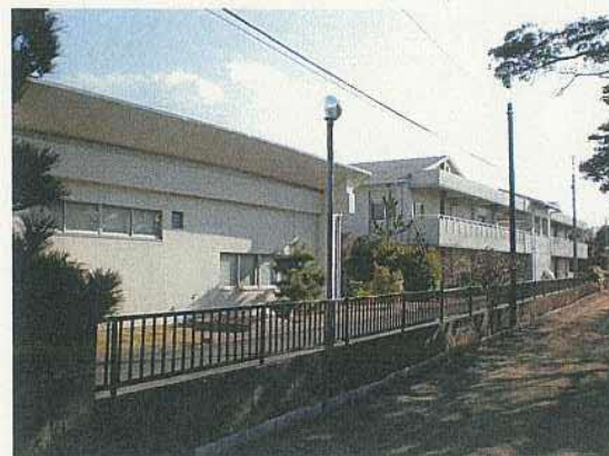
写真 5. 3. 14 労災リハビリテーション 千葉作業所 (敷地中央)
