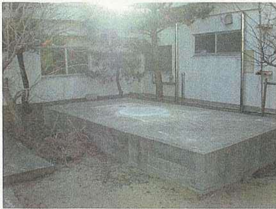
写真 5. 3. 5 地下タンク貯蔵所跡
