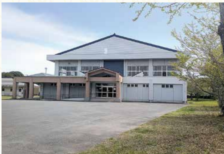
空調設備設置予定の白子中学校体育館
